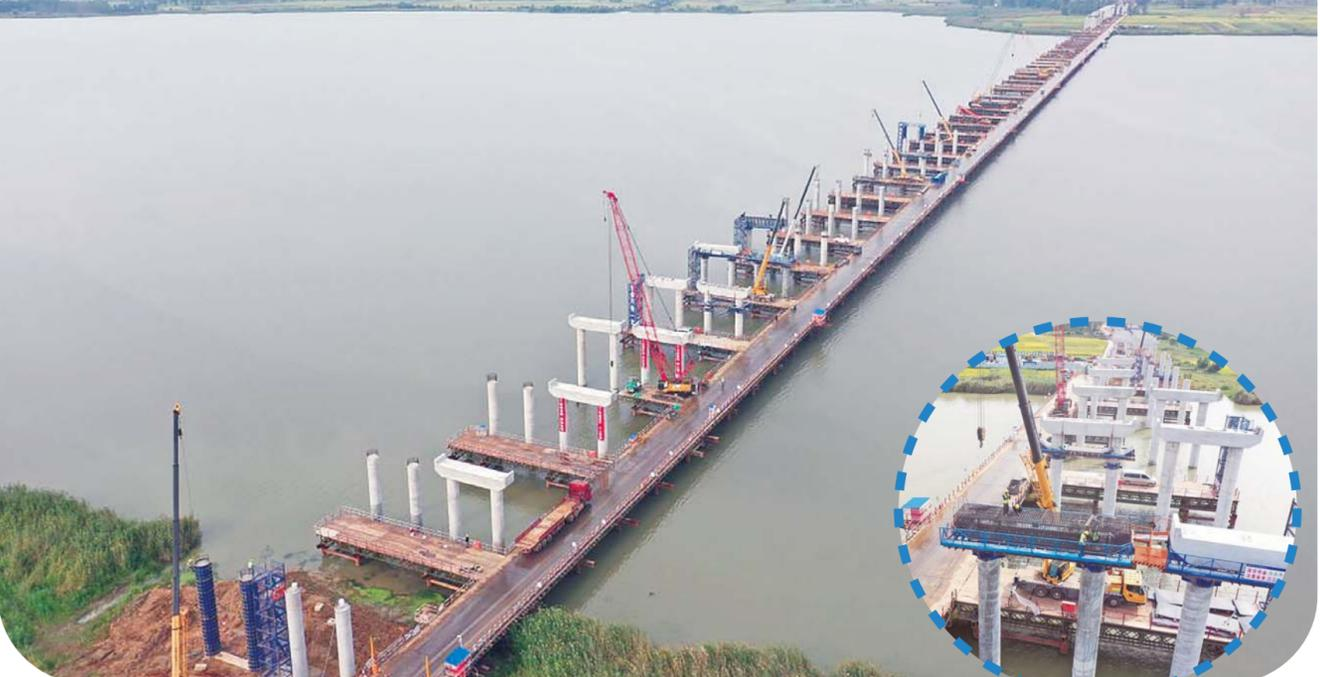
本报讯(融媒体记者 李景 通讯员 饶映文/图)近日,在五蒙高速沱湖特大桥施工现场,伴随着混凝土搅拌车的轰鸣声,沱湖特大桥44#墩-0#桩基最后一方混凝土浇筑完成,至此沱湖特大桥420根桩基施工全部顺利完成。这标志着五蒙高速项目建设取得又一重大节点成果。
