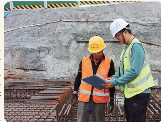
王存磊（右一）在施工现场检查工程质量。
