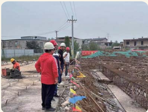
临港片区建设者正在施工市政道路。
