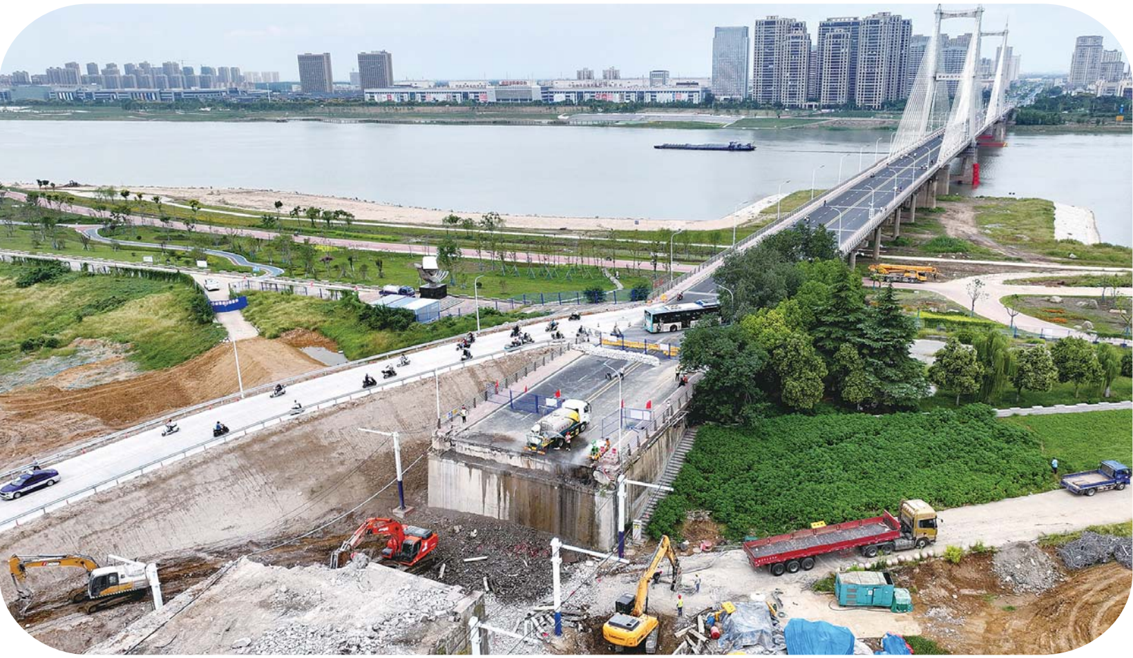
图为滨河南路下穿解放路淮河大桥工程现场（无人机照片）
