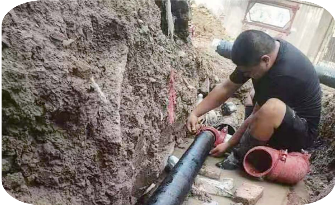
施工工人正在对小区消防设施进行大修。
