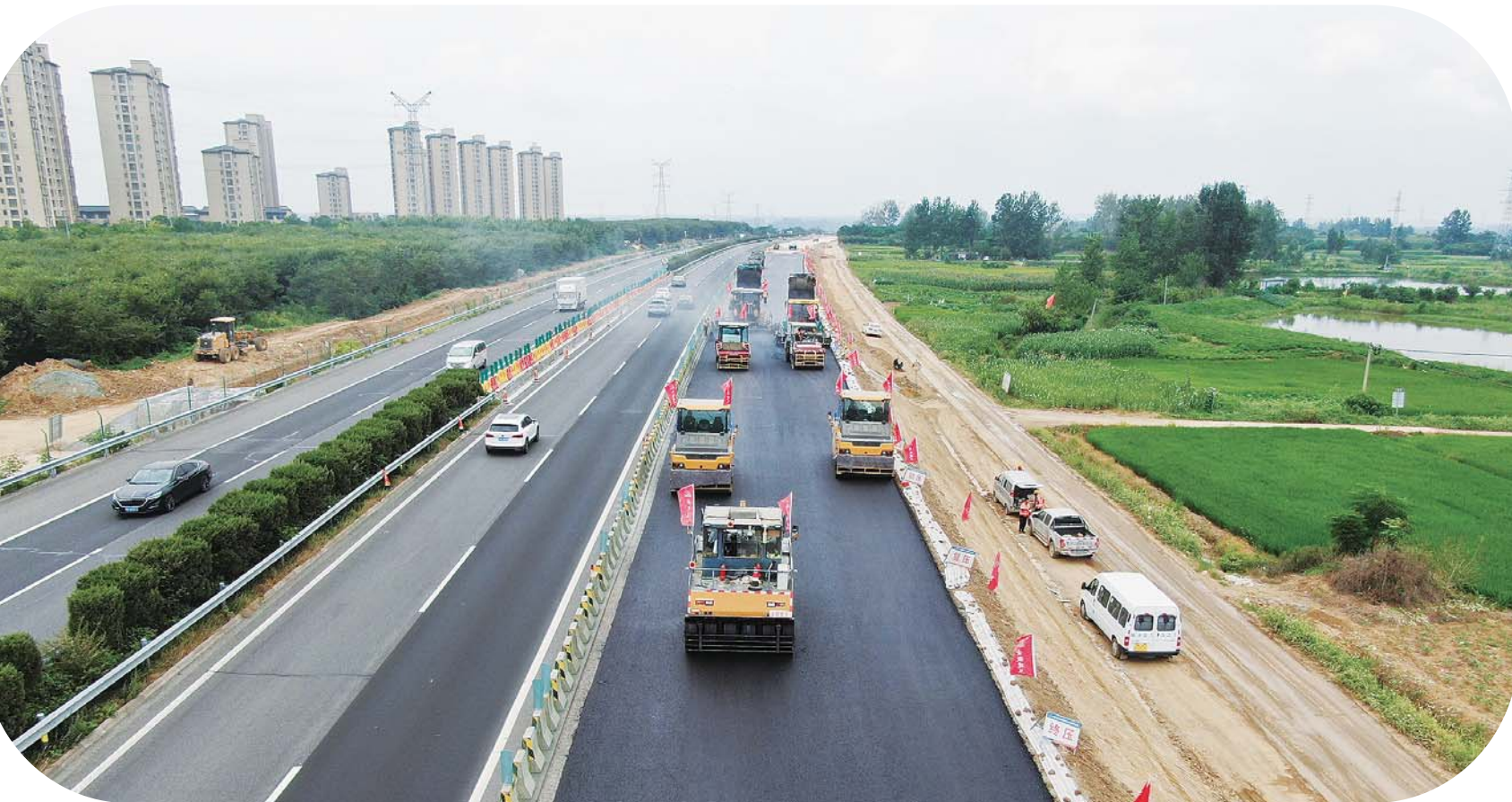
项目进入路面施工阶段。
