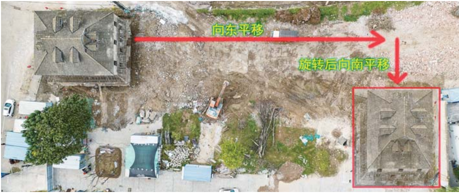
上图：正在进行平移施工中的宝兴面粉厂阁楼。 左图：宝兴面粉厂阁楼平移示意图。
