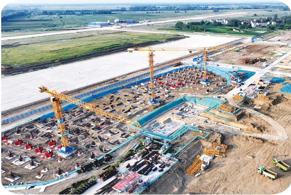
8月23日,蚌埠民用机场航站区航站楼及附属工程正在紧张施工中(无人机照片)。
