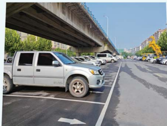
改造后的淮河大桥桥下停车场，有效缓解群众停车难。
