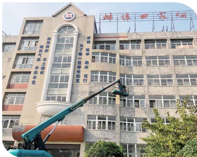
校园基础设施升级改造现场。
