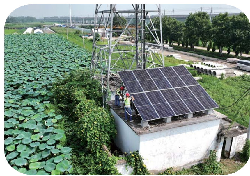
8月16日,淮上区曹老集镇杜陈村杜桥中心村,安徽移动蚌埠分公司5G工程施工人员站在杜桥基站机房顶上安装太阳能光伏发电装置。
