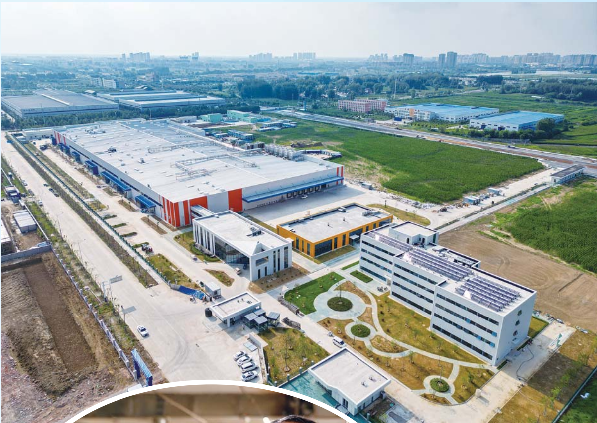
固镇大成食品二期项目建设现场。
