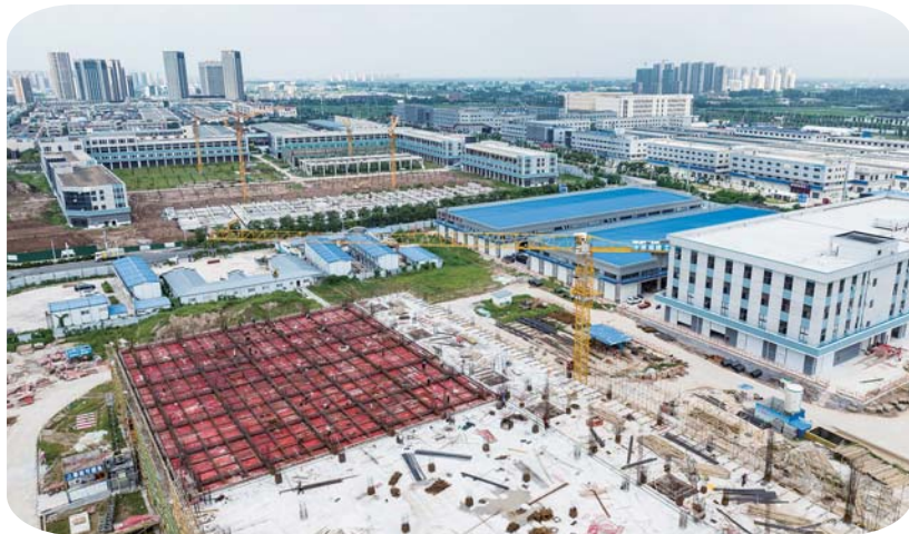
合一冷链物流园三期项目建设现场。融媒体记者 陈昂 摄
