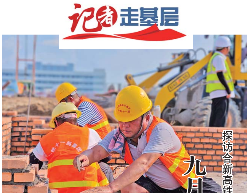
工人正在施工作业。
