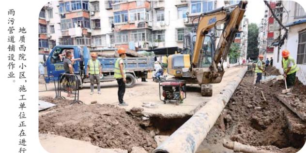
雨污管道铺设作业。地质西院小区，施工单位正在进行
