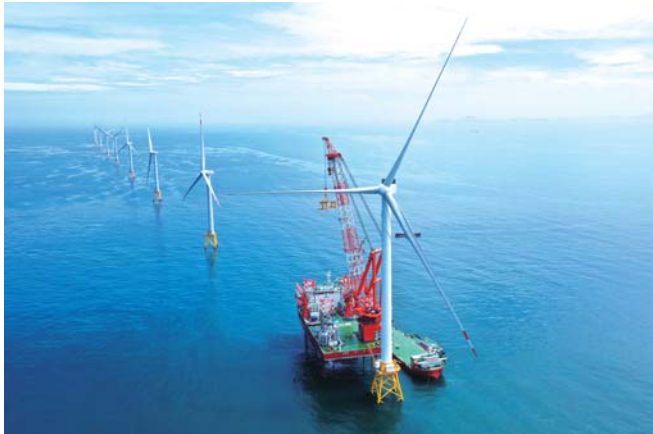
这是16兆瓦超大容量海上风电机组安装完成现场(6月28日摄,无人机照片)。7月19日,16兆瓦超大容量海上风电机组在三峡集团福建海上风电场成功并网发电,标志着我国海上风电大容量机组研发制造及运营能力再上新台阶。新华社记者 林善传 摄
