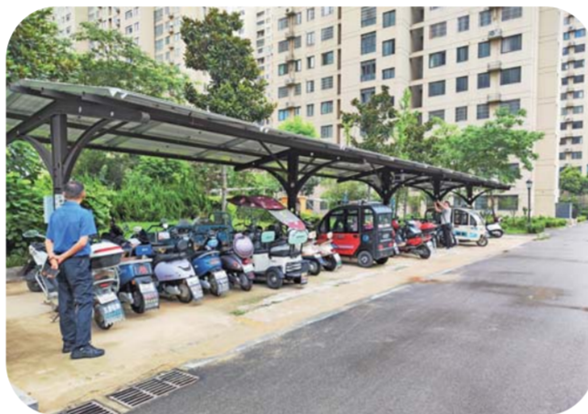
治理“飞线充电”,凤凰城小区打造的“光伏电动车充电桩”,不仅便民利民,更加绿色环保。
