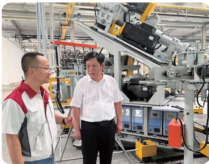
符布刚(左)来到诺博汽车橡胶(安徽)有限公司一期项目,向总经理田品询问设备安调调试进展情况。
