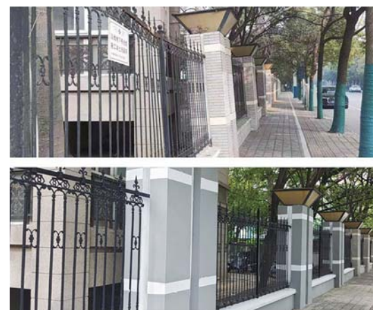
拼版图片:上图为沁淮花园小区围墙修缮前;下图为围墙修缮后,焕然一新。近日,沁淮社区纪检工作找准居民“需求点”,围绕居民生活中的难点、痛点、堵点问题,聚焦办理民生实事,及时修缮沁淮花园小区问题围墙。 通讯员 付艳 摄
