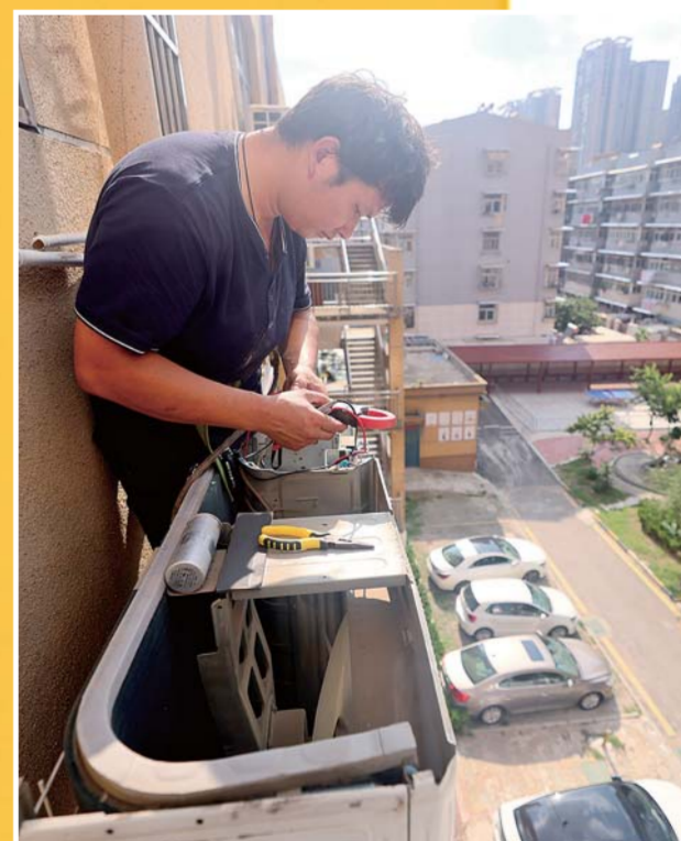
7月9日,空调安装维修工刘响身绑安全带检修空调。
