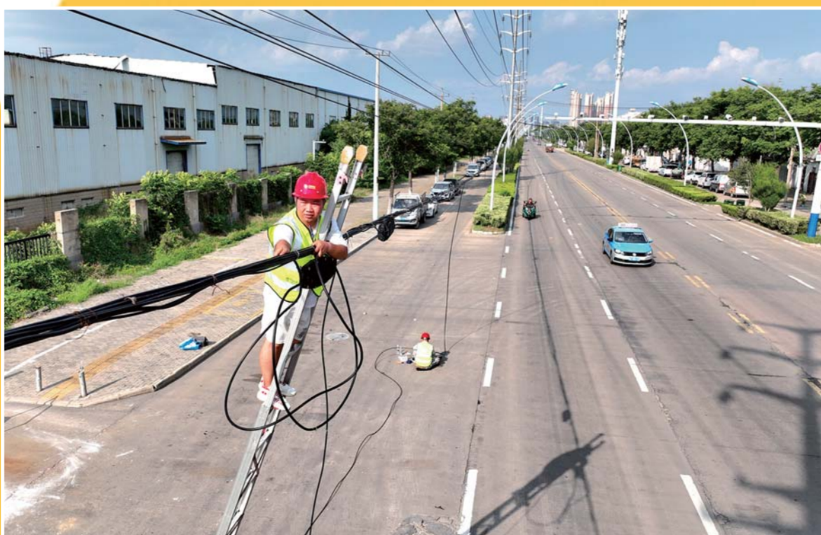
7月9日,烈日当头,安徽移动蚌埠分公司工程抢修人员抢修被车辆刚断的光缆。
