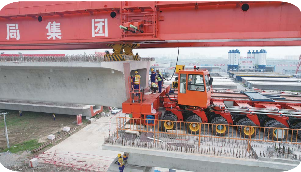
日前,淮宿蚌城际铁路站前Ⅳ标段一桥长32.6米、重达790吨的高速铁路箱梁在固镇西特大桥架设成功。
