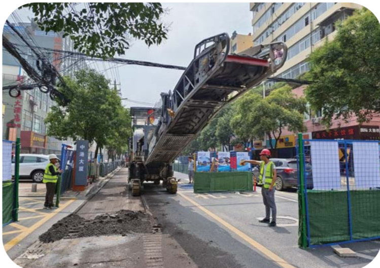
淮河路改造提升,工人正在操作铣刨机铣刨路面。
