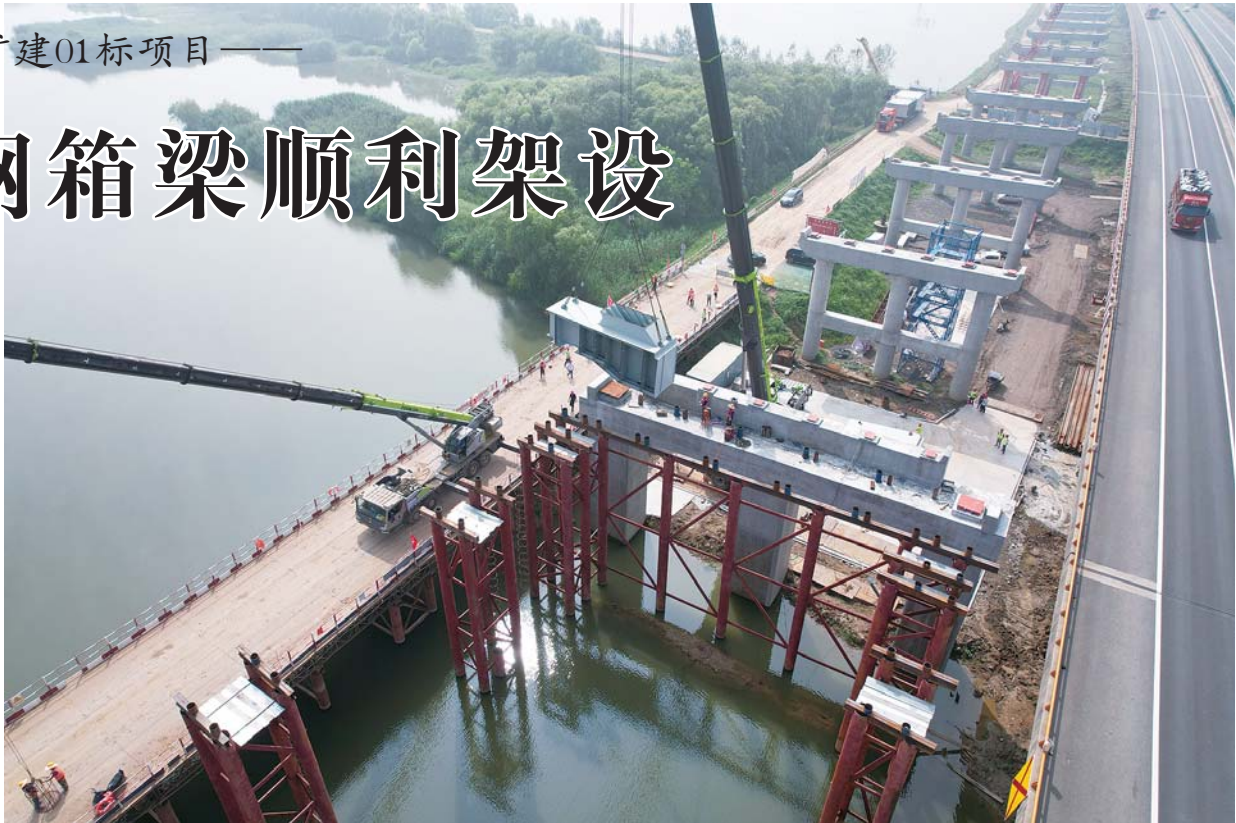
G36宁洛高速蚌明改扩建01标项目首片钢箱梁顺利架设。
