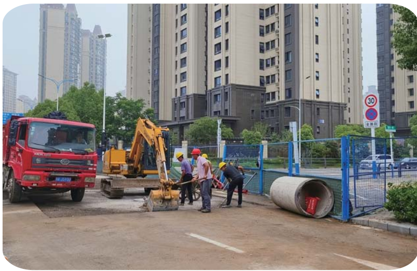
滨湖片区的污水管网改造现场,工人们正在进行收尾工作。
