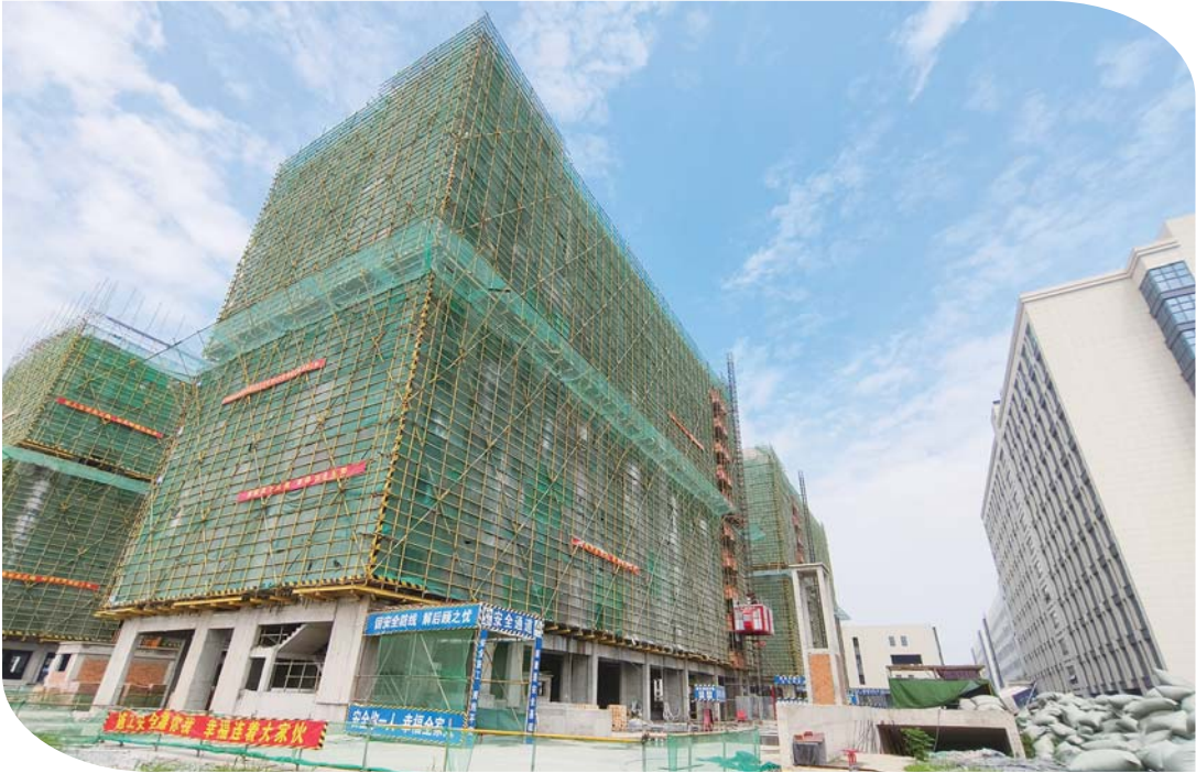
日前,禹会区新型智造双创园EPC项目正在加紧建设。
