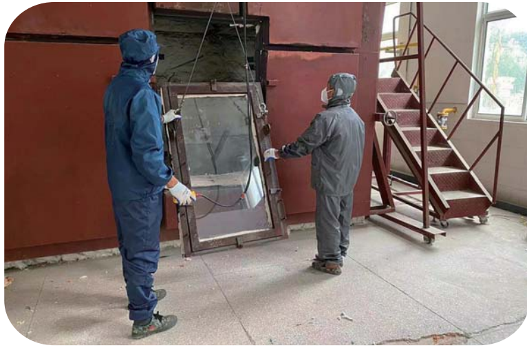
耐火样品安装、吊装。
