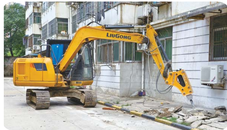
皖酒小区,履带式破碎机正在作业。
