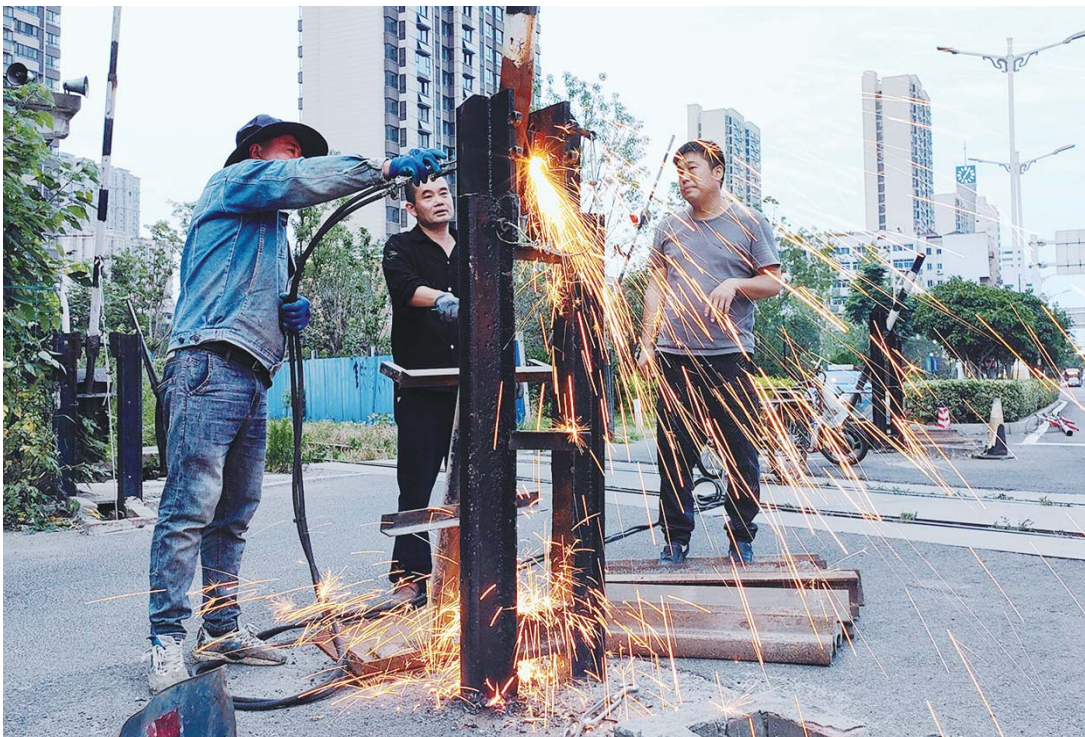
6月16日傍晚，工作人员开始拆除胜利西路西货场铁路专线道口设施。
