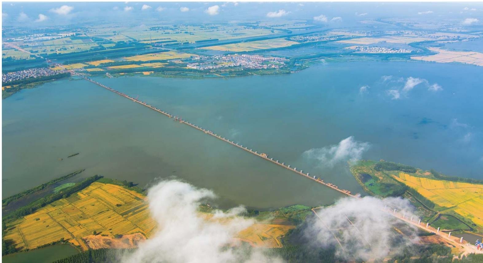
合新高铁怀洪新河特大桥加紧施工，其中3公里贯穿沱湖保护区及南北河堤，是全线重难点工程。
