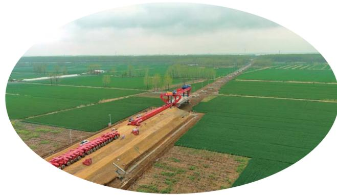
4月4日，随着一长326米、重800吨箱梁缓缓落在怀洪新河特大桥458号-459号桥墩（台）上，标志着合新铁路项目开启双机双向架梁施工，线上作业全面展开。
