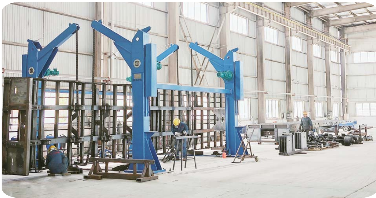
企业正在安装新设备的车间，6月就可以投用。
