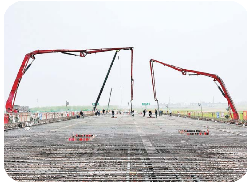
淮河特大桥首孔现浇梁顺利浇筑完成，标志着项目全面进入上部结构施工阶段。
