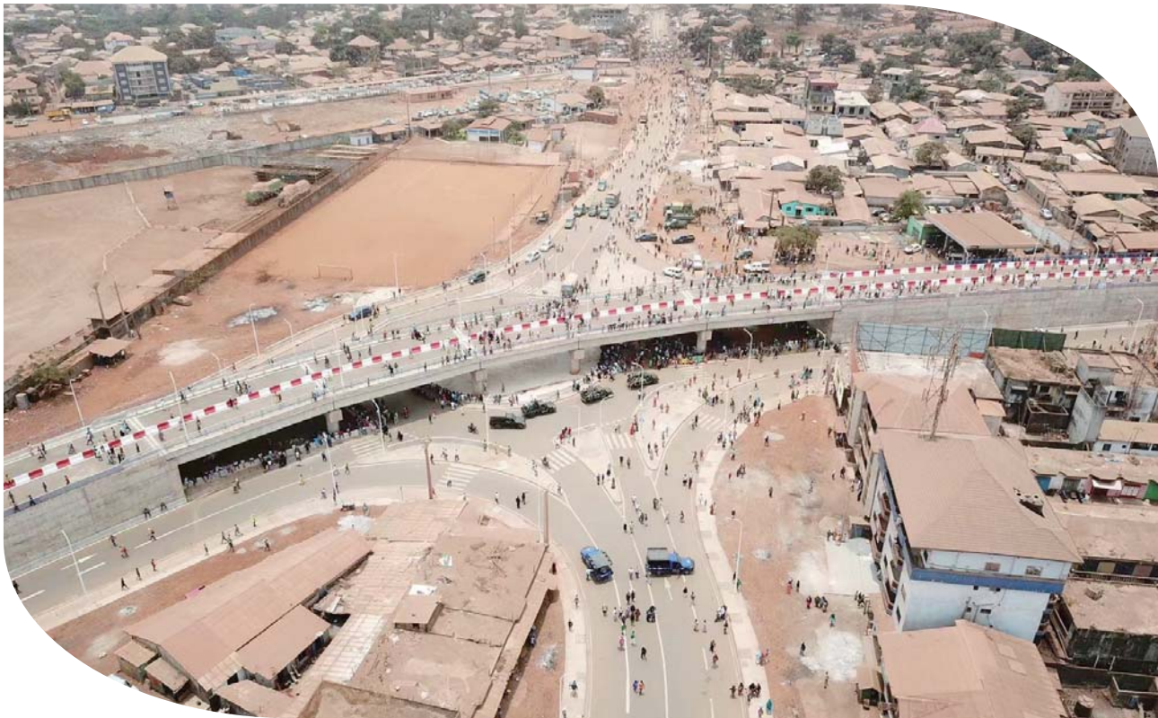
蚌企承建的卡格贝伦立交桥正式竣工通车。
