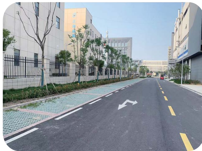
图为禹会区微机电双创产业园项目停车场。
