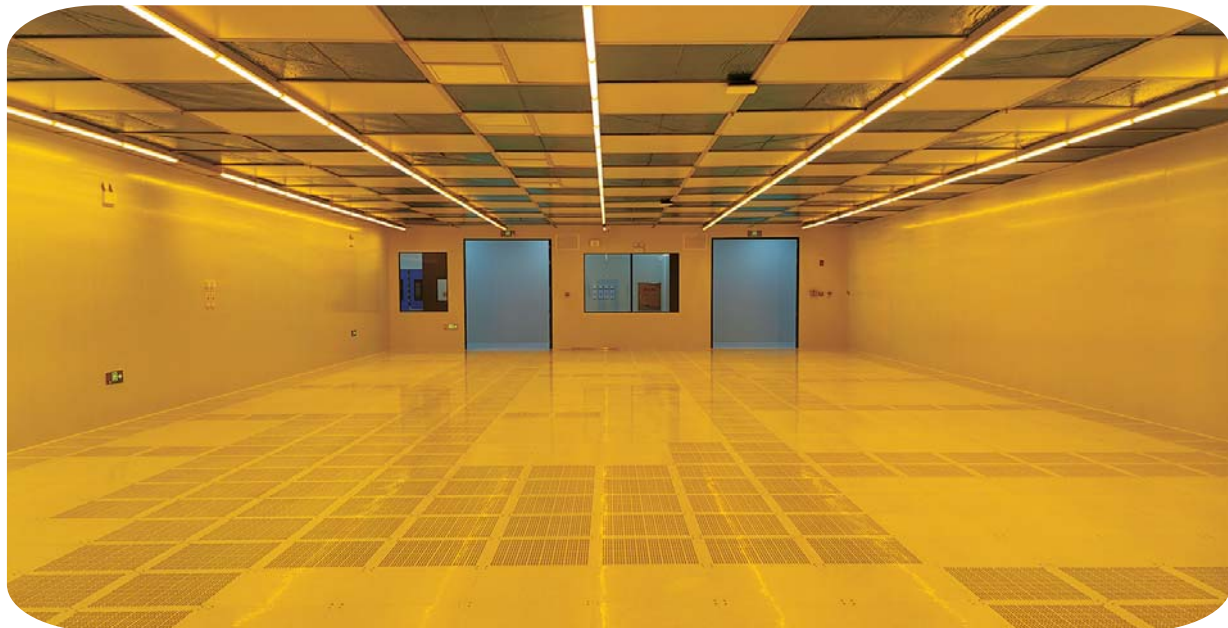
图正在进行净化改造的厂房。
