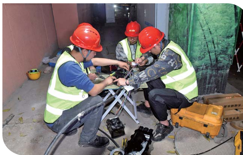
凤阳路(国富街-圈堤路)架空光缆入地工程现场，蚌埠移动施工突击队开展夜间的光缆割接。
