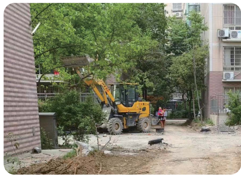
龙湖香都小区正在实施提升改造工程。
