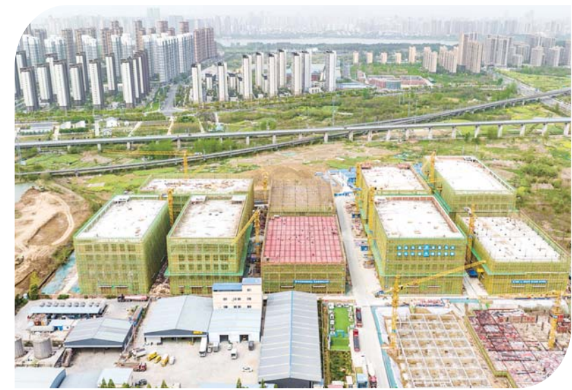
作为市重点项目,龙子湖区高新电子产业园三期EPC项目目前进展过半,6栋厂房已经封顶,4栋厂房正在进行主体工程建设,研发楼正在进行地下室施工。该项目位于锥子山路西侧、望山路南侧,总建筑面积177216平方米。
