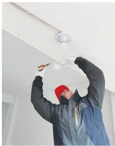
物业人员维修楼道灯。
