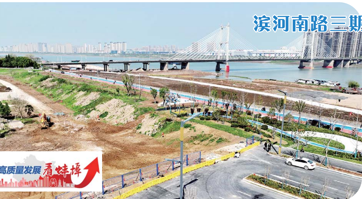
4月7日,航拍滨河南路东段(解放一路—新城路)施工段。
