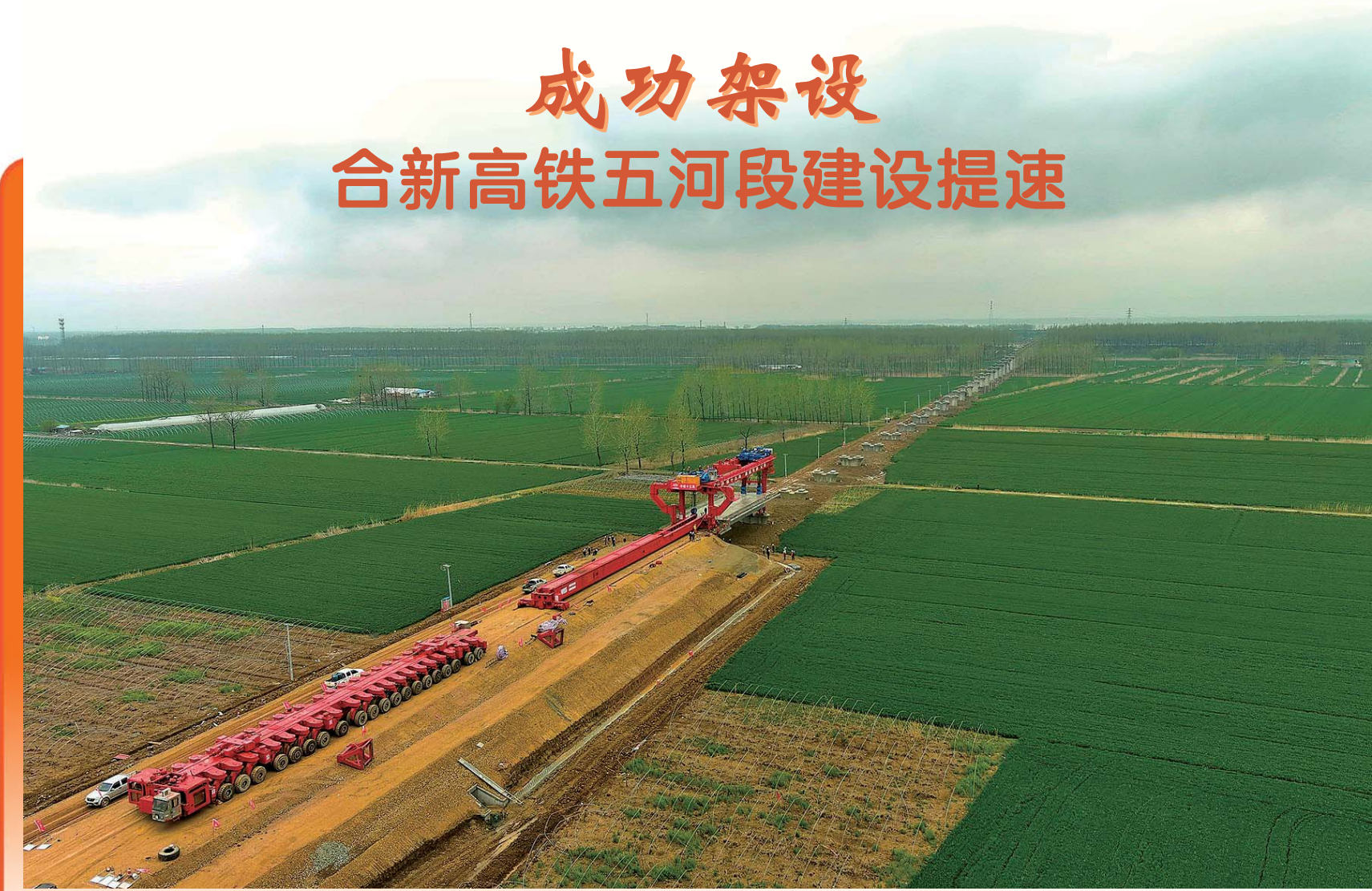
4月4日，随着一捆长32.6米、重800吨箱梁缓缓放落在怀洪新河特大桥458号—459号桥墩(台)上，合新高铁五河制梁场首捆箱梁成功架设，标志着合新铁路项目开启双机双向架梁施工，线上作业全面展开。 据介绍，合新高铁项目(合肥至新沂段)工程全长约330公里，其中安徽省境内约221公里，途经泗县、五河、明光、凤阳、定远、肥东，设计速度350公里/小时。 由中铁十五局承建的五河高铁站项目，全长25.9公里，合同工期为3年半，车站为2站台6线设计，包括高铁客运专线和城际线预留口，施工内容包括车站桩基处理、5座涵洞、1座地道、惠民路中桥、龙潭湖中桥、兴涂西路中桥、无砟轨道等工程，预计2024年底完成全部施工。届时，随着合新高铁全线通车，五河县将从不通铁路直接迈入高铁时代。
