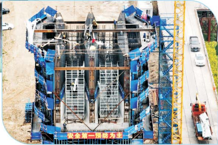
作为淮宿蚌城际铁路重难点控制性工程，跨淮河矮塔斜拉桥正式进入梁部施工阶段。
