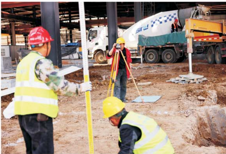
五河县丽岛新能源电池集流体材料项目建设现场，施工人员按照标准作业。
