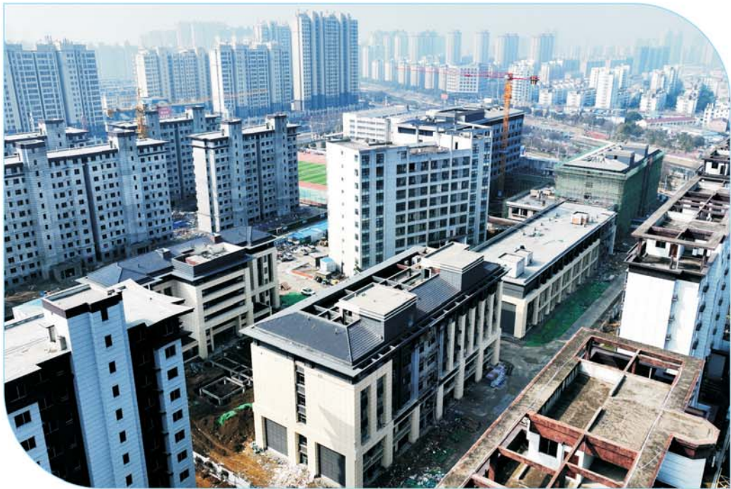
建设单位抢抓进度，力争固镇县养老服务中心项目年底竣工验收。
