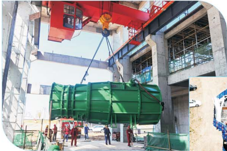
作为“靓淮河”重点工程之一，龙子河水利枢纽工程泵站进行水泵安装，主体基本完成。
