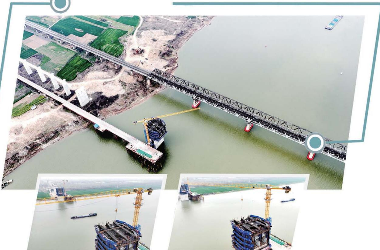
本报讯(融媒体记者 陈昂文/图)作为淮宿蚌城际铁路重难点控制性工程，跨淮河矮塔斜拉桥正式进入梁部施工阶段。该桥位于我市京沪货运铁路线淮河铁桥下游80米，全长497.5米，为重难点控制性工程。
