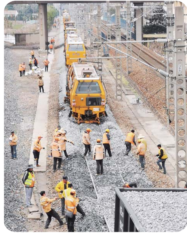
取旧料、换新轨、忙焊接……近日，中国铁路上海局集团有限公司多部门分工协作，在蚌埠市内利用大型机械与人工配合，对铁路京沪线蚌埠地区线路进行精细化养修，为旅客安全出行提供有力保障。融媒体记者 陈昂 摄
