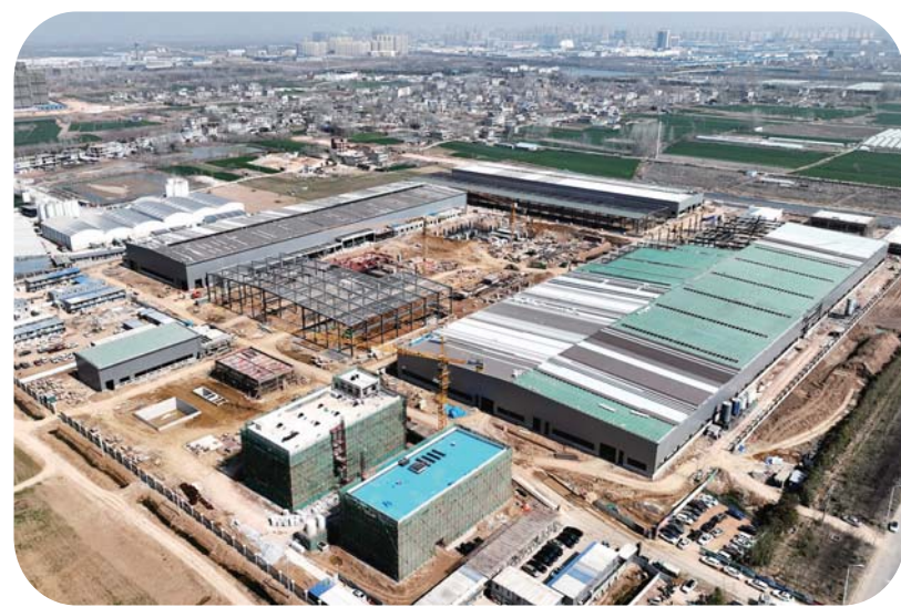
航拍五河县丽岛新能源电池集流体材料项目建设现场。
