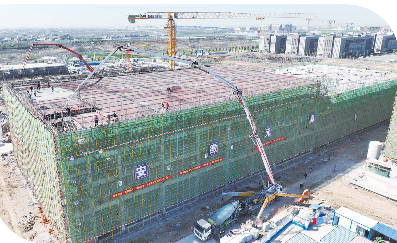
热火朝天的施工现场。
