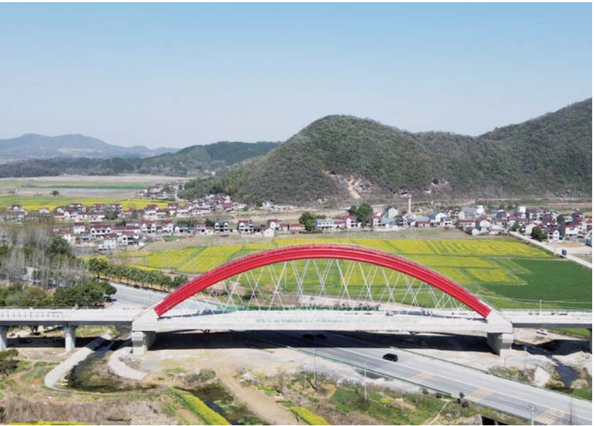
这是3月14日拍摄的中铁十一局池黄铁路无砟轨道施工现场（无人机照片）。近日,在中铁十一局池(州)黄(山)铁路建设现场,工人们抢抓工期进行无砟轨道施工,为后续铺轨打好基础。池黄铁路全长约125公里,设计时速350公里,是武(汉)杭(州)快速铁路通道的重要组成部分。
