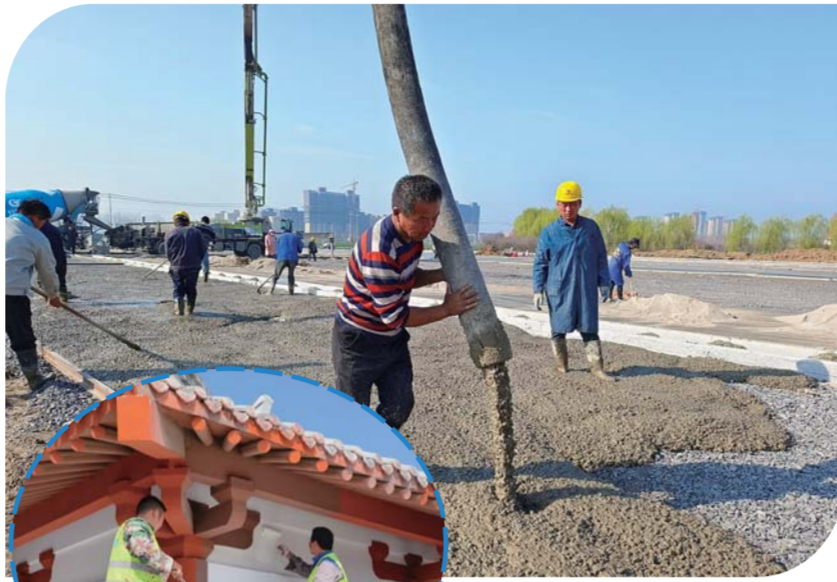
施工人员加班加点赶进度。
