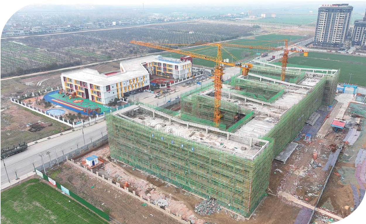
建设中的北城小学工程项目。融媒体记者 刘晨 摄
