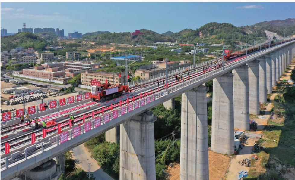
2月23日，中铁五局承建的广汕铁路正线最后一组500米长轨在汕尾东冲特大桥铺设完成，该线正线铺轨实现贯通。广汕铁路是“轨道上的大湾区”高铁骨干网重要组成部分，该线全长202公里，时速350公里，途经广州、惠州、深汕特别合作区、汕尾。全线通车后，广州到汕尾运行时间将缩短至1小时以内。新华社记者 刘大伟 摄
