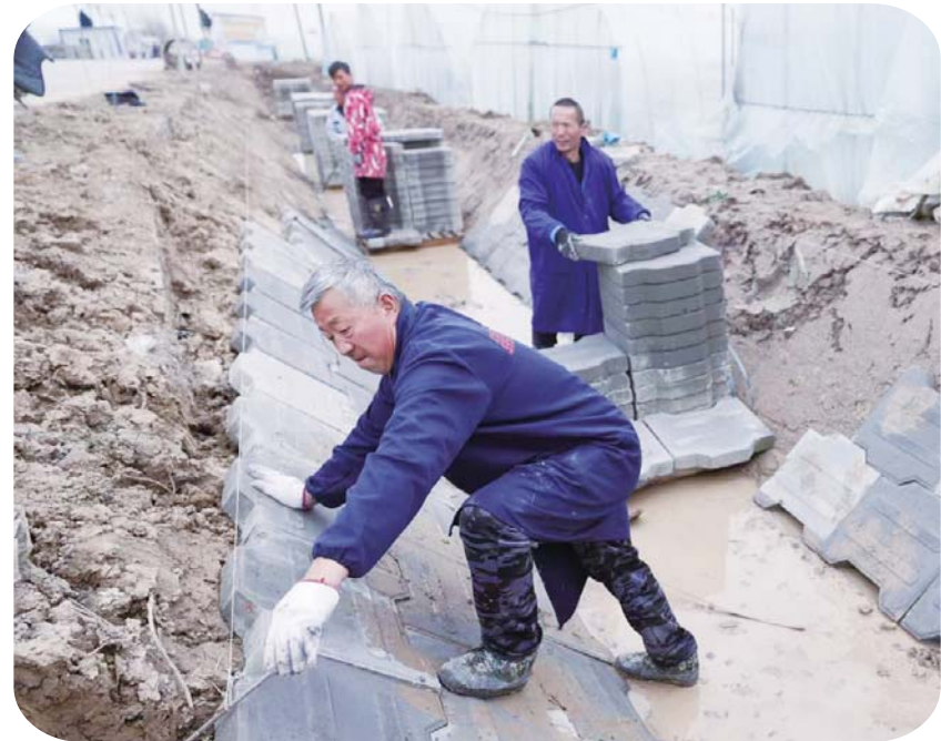
2月16日,梅桥镇胡口村施工人员正在铺设水渠砖。眼下,淮上区梅桥镇高标准农田建设项目正在施工,项目涉及四个村,共整理土地16000亩,新修道路12.2公里,清理大小沟渠170条,拆除重建电站4座,配套农田电网780米、道
