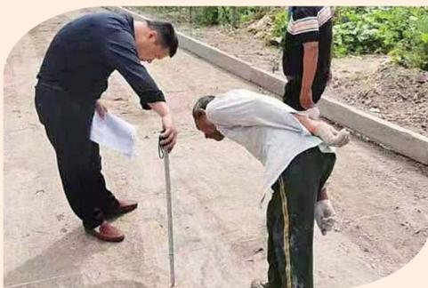
检查待浇筑混凝土厚度。
